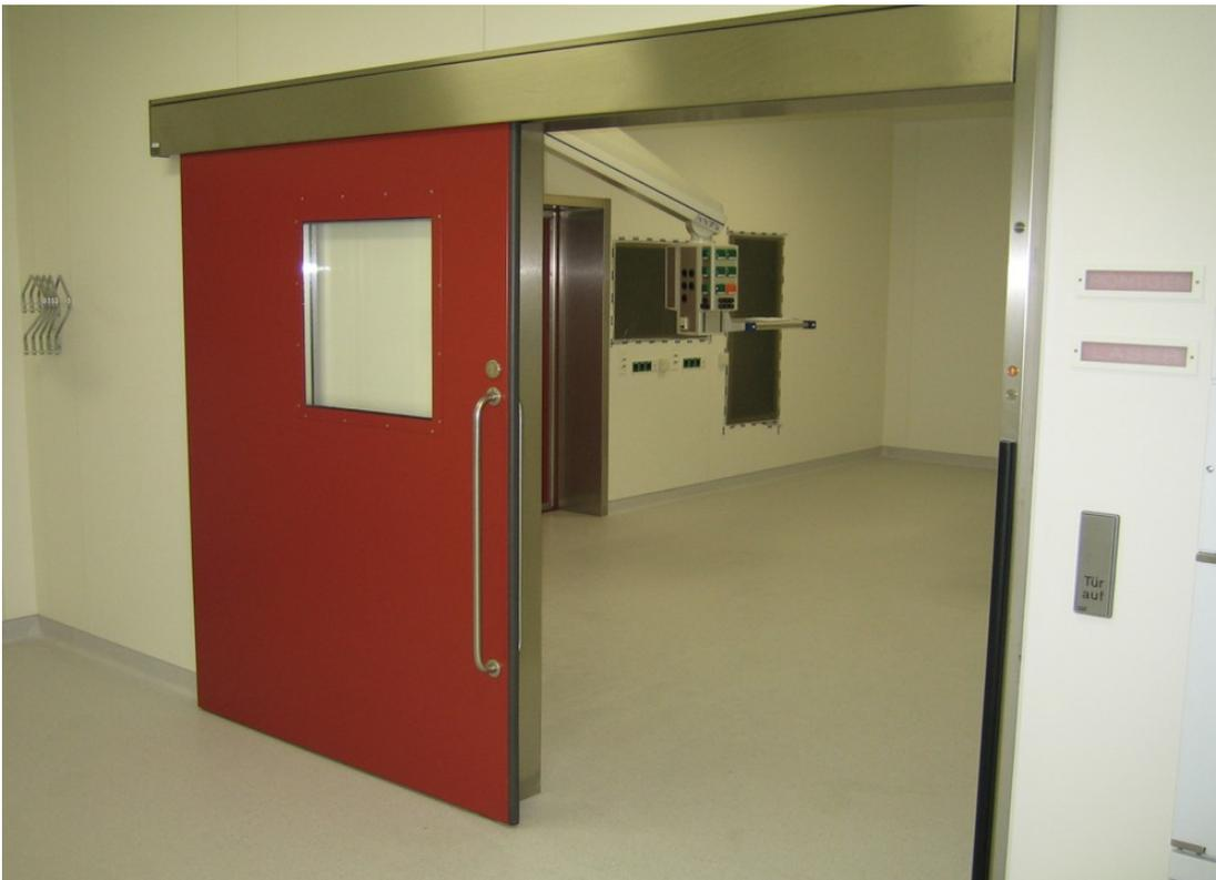
*Einflügelige Edelstahl-Feuerschutztür T30 mit flächenbündiger Jalousieverglasung, Schnelllaufantrieb und Rauchschutzdichtungen nach DIN 18095 (Bild: [www.system-schroeders.de](http://www.system-schroeders.de))*
