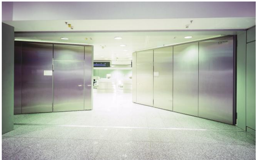
Zweiflügeliges Drehflügelator, Flughafen Frankfurt a.M.
