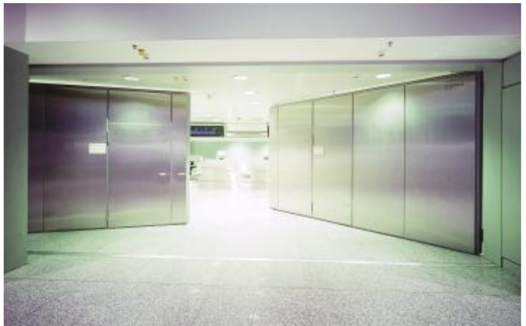
Zweiflügeliges Drehflügelator, Flughafen Frankfurt a.M.
